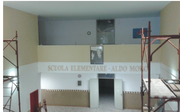
« in alto, area esterna scuola primaria A. Moro « qui sopra, lavori antisfondellamento atrio scuola primaria A. Moro
